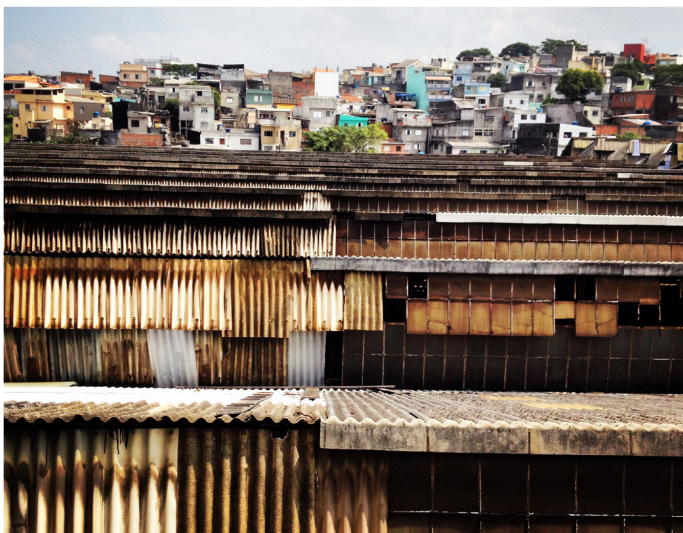
Imagem 01. Bairro Centro, tipologia industrial e residencial, Diadema. Idom/2014
