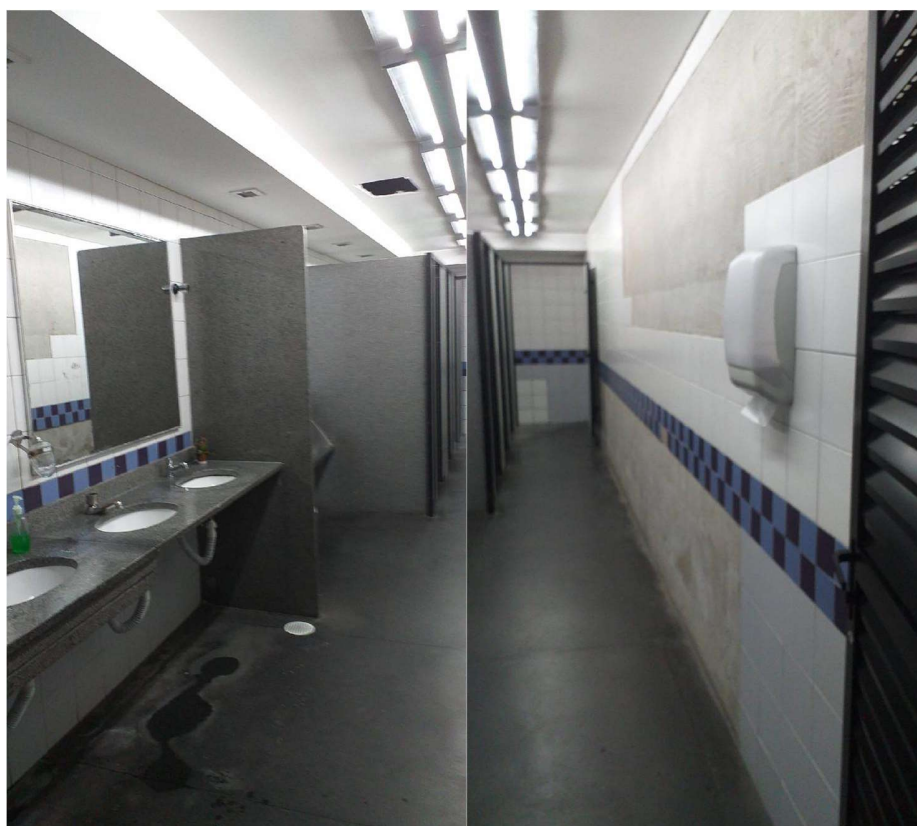
Figura 4- Banheiro do Ed. II
