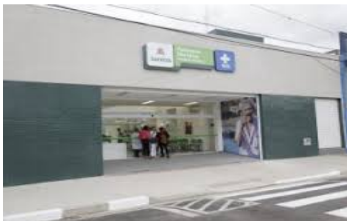
Figura 7 – Fachada da Policlínica Vila Nova
